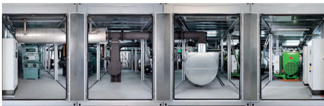
Combinazione di potenza, riscaldamento, raffreddamento e vapore in Lactoprot, una fabbrica di derivati del latte nel nord della Germania.
